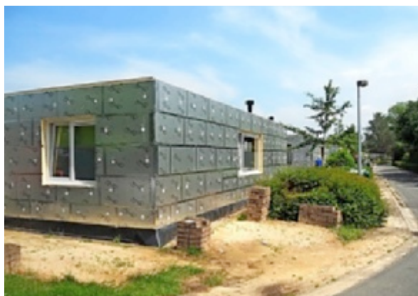
Woningen worden in een eerste fase volledig ingepakt met isolatie.
