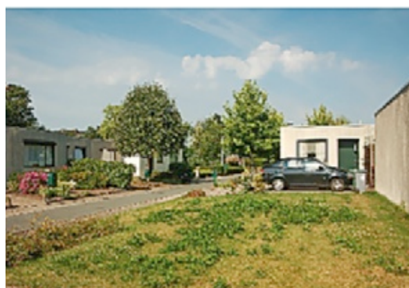
Situatie vóór renovatie
