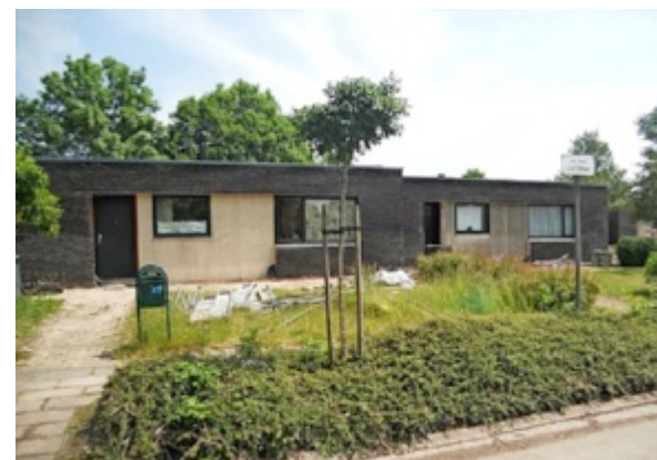
Oude betonstructuur voorlopig nog zichtbaar.
